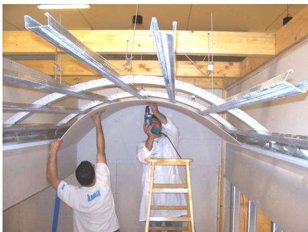
PROVA PRATICA PER LA POSA DI SISTEMI COSTRUTTIVI A SECCO IN CARTONGESSO
