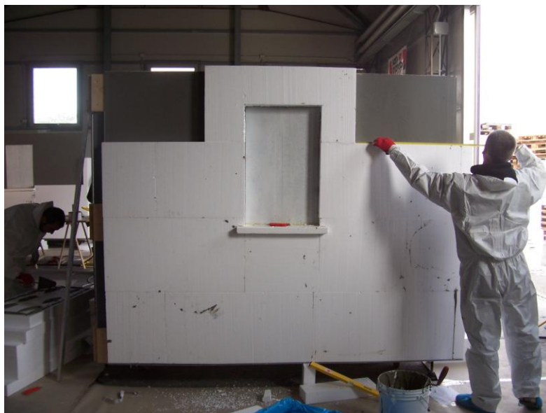
PROVA PRATICA PER LA POSA DI SISTEMI "A CAPPOTTO" PER L'ISOLAMENTO TERMICO ESTERNO DEGLI EDIFICI
