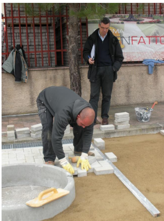
PROVA PRATICA PER LA POSA E MANUTENZIONE DI MASSELI AUTOBLOCCANTI
