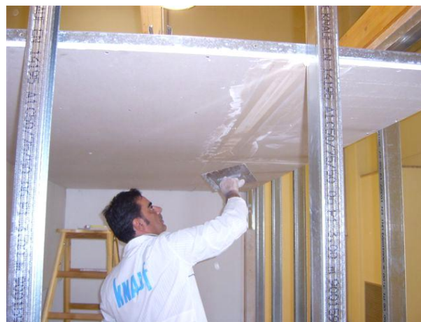
PROVA PRATICA PER LA POSA DI SISTEMI COSTRUTTIVI A SECCO IN CARTONGESSO
