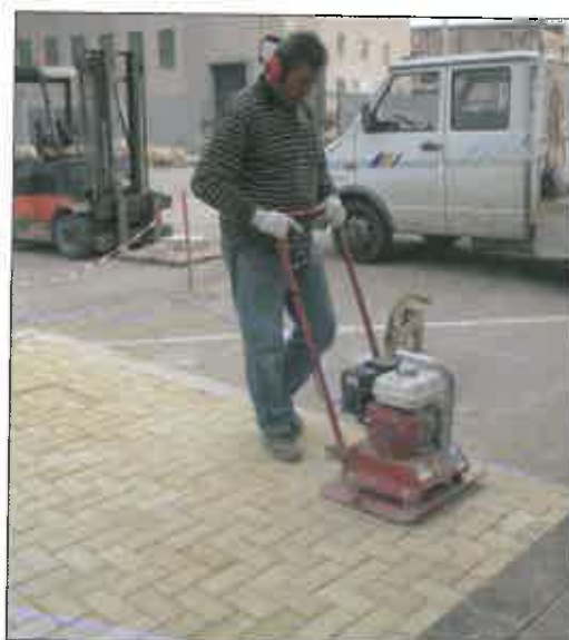
Vibrazione/pattinazione dei masselli dopo l'armamento del giunto
