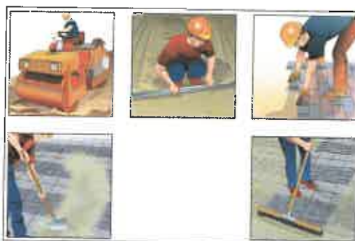
Fasi della posa dei masselli autobloccanti in calcestruzzo (sono del Codice di pratica ASSOBETON/ENI-VOL)
