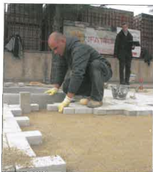
Posa dei masselli in corrispondenza di un "elemento critico" (prova pratica d'esame)
