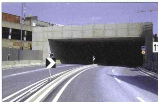
Figura 3 - Una pavimentazione trattata con Coverlite®
