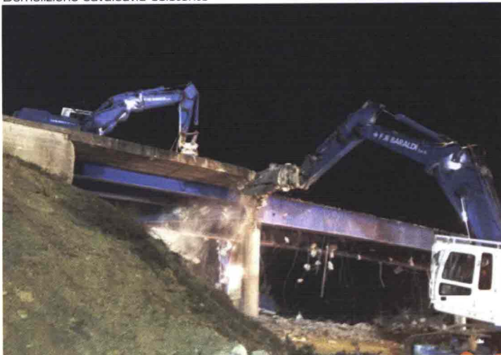
Demolizione cavalcavia esistente
