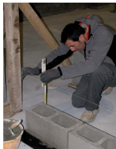
Il controllo dell'allineamento con calandro orizzontale (per gentile concessione Centro Pose Spa).
